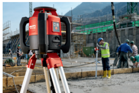
基礎工事でのレベルチェック。
