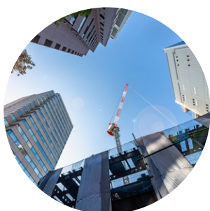
上空視界の狭い 都市部工事
