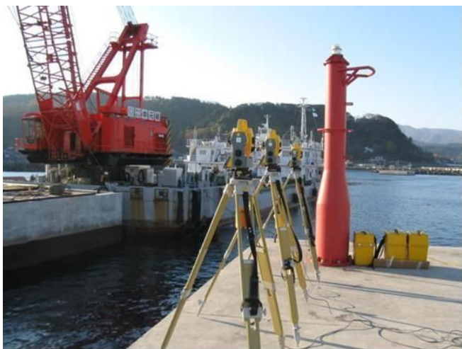
ケーソン据付への適用事例
