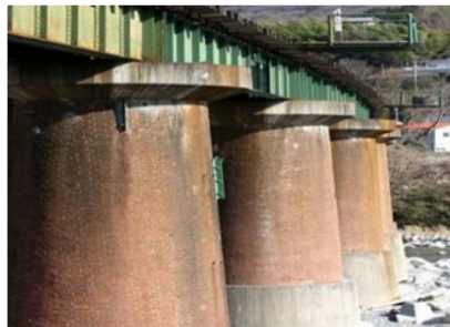
老朽化橋梁のクラック幅変位計測
