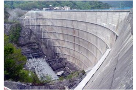
老朽化ダムของクラック幅変位計測
