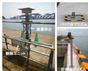
●港湾構造物変位(地盤改良の影響監視)
