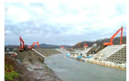
③**河川掘削（浚渫（シュンゼツ））工事**・・・河川は流れが有るので、どうしても上流の土や砂が下流に流れていきます。
